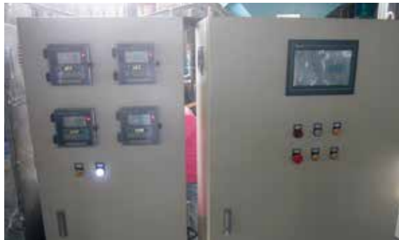
台灣廠區裝設水質偵測與補水系統
