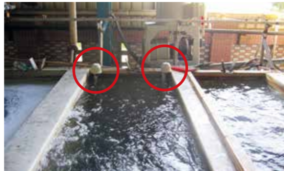
台灣廠區裝設水質偵測與補水系統
